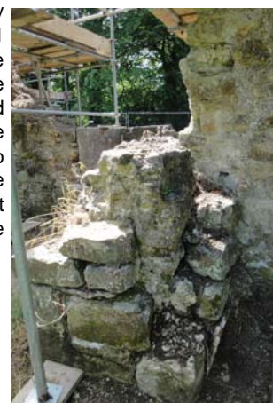
Right:- Buttress (F13).
